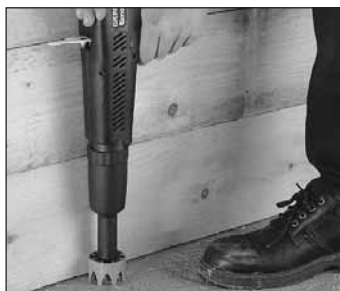
Setzen von Schalungsanschlagen
