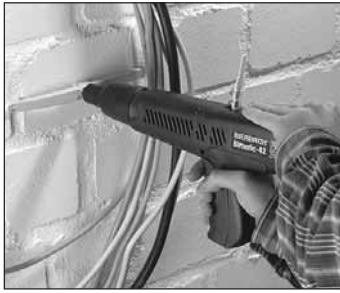
Setzen von Kabelbügeln
