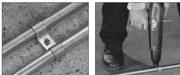
Rohrbefestigung mit Fixbriden
