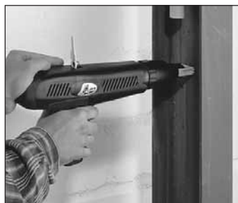
Elektrorohrbefestigung
