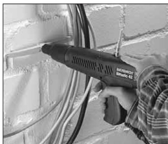
Setzen von Kabelbugeln
