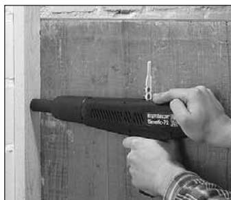
Montage von Holzlaten
