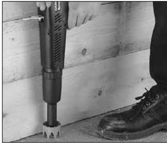
Setzen von Schalungsanschlagen
