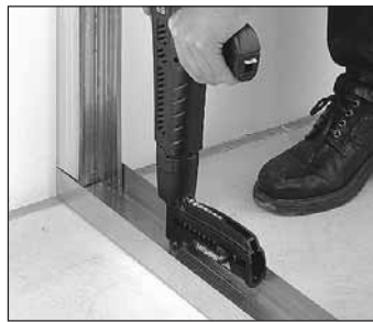
Befestigung von Trockenbauprofilen
